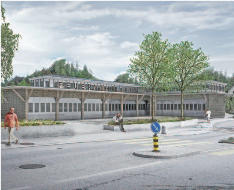
Das älteste Feuerwehrgebäude im Kanton Zürich aus dem Jahr 1936 weicht einem Neubau.
